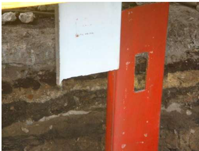
Мал. А.10. Занурення елемента шпунтової палі для використання в якості переміщуваного (мобільного)
