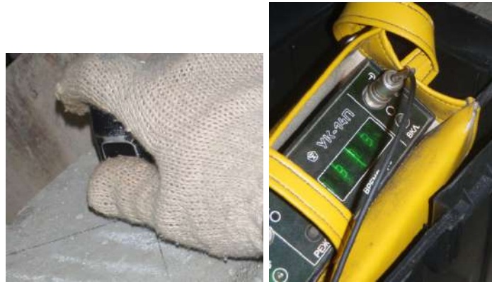
Рис. 2.15 Прозвучування балки ультразвуковим приладом УК-14П
