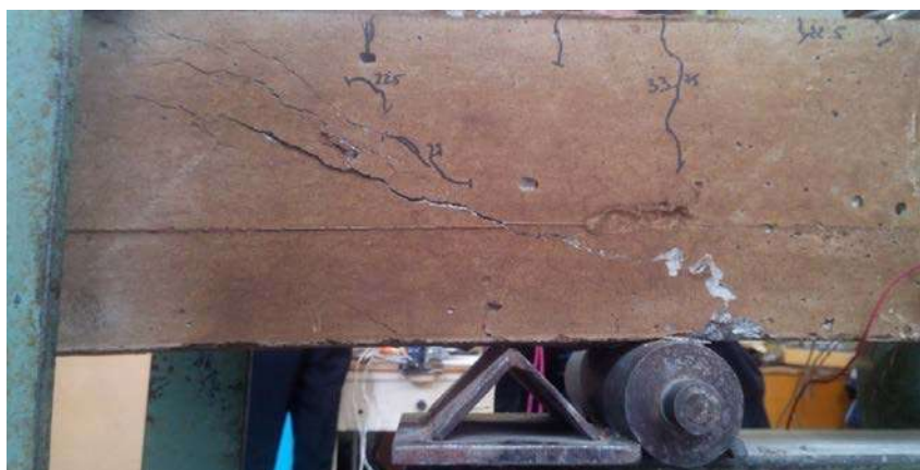
Рис. 3.12 Роздроблення бетону стиснутої зони
