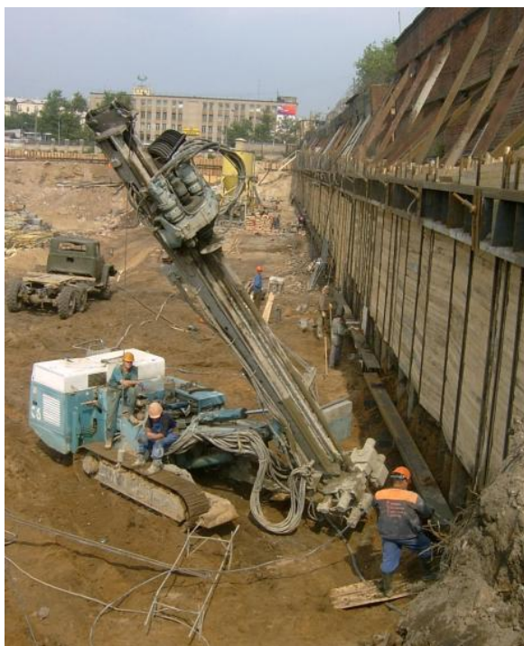
Рисунок 1.6. Установка анкерів другого ярусу
