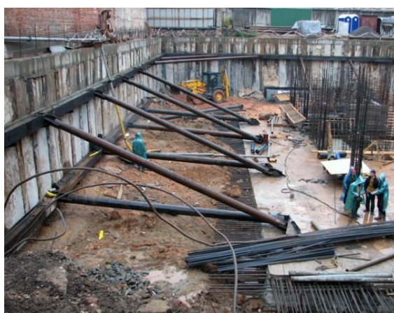
Рисунок 1.8. Розпирні кріплення з упором на днище котловану
