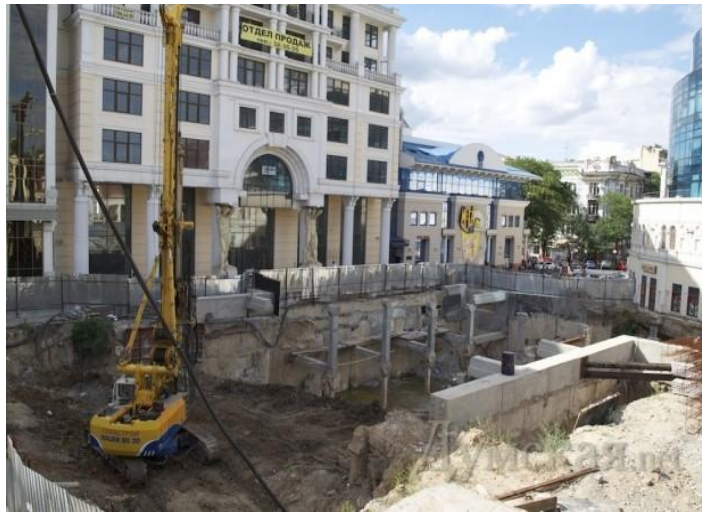
Рисунок 1.2. Будівництво підземного паркінгу в місті Одеса
