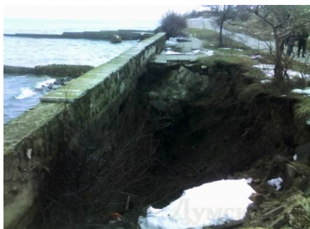
Рисунок 1.12. Друга стадія руйнування підпірної стінки
