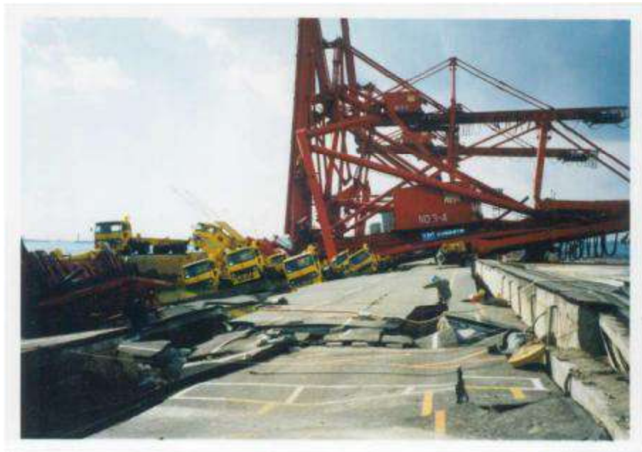
Рис. 3.9. Пошкодження причальної стіни в порту Кобе під час землетрусу в Хегокен-Нанбу в 1995 році.
