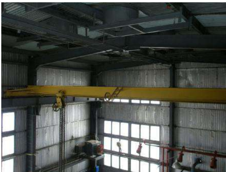
Рис. 4.11 – Вигляд на кут в осях «1» «А-Б»
